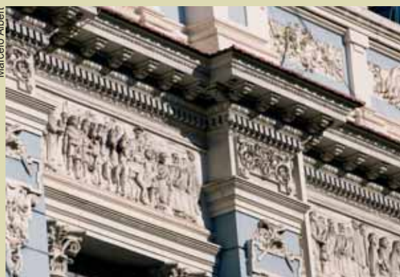
O edifício ainda mantém grande parte da sua arquitetura original
